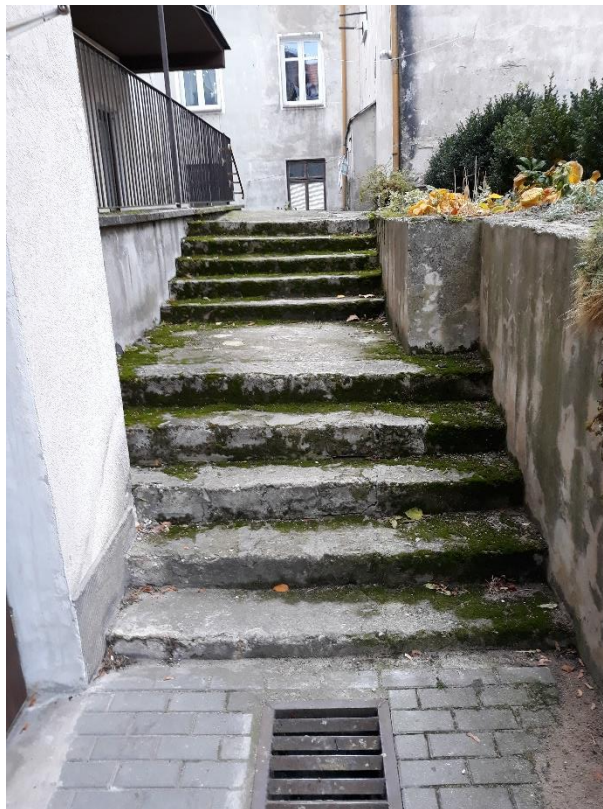
Zdjęcie schodów betonowych – widoczne spękania schodów
