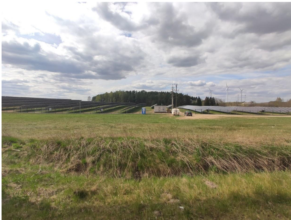
Widok na instalację fotowoltaiczną
