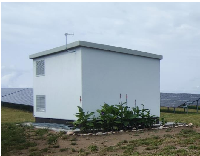
Kontenerowa stacja transformatorowo-rozdzielcza
