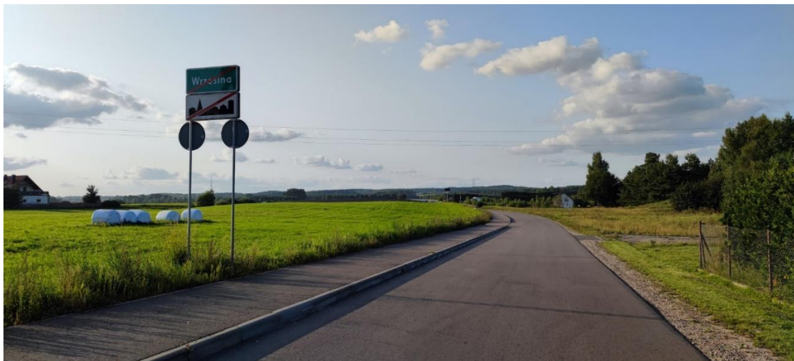
Widok na instalację fotowoltaiczną
