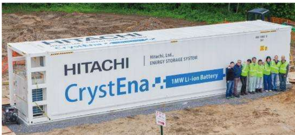
Ryc. 11 Przykładowy kontenerowy magazyn energii o pojemności 1 MW, Hitachi „CrystEna”. Inwestor planuje zastosowanie wtapiających się kolorów kontenera.
