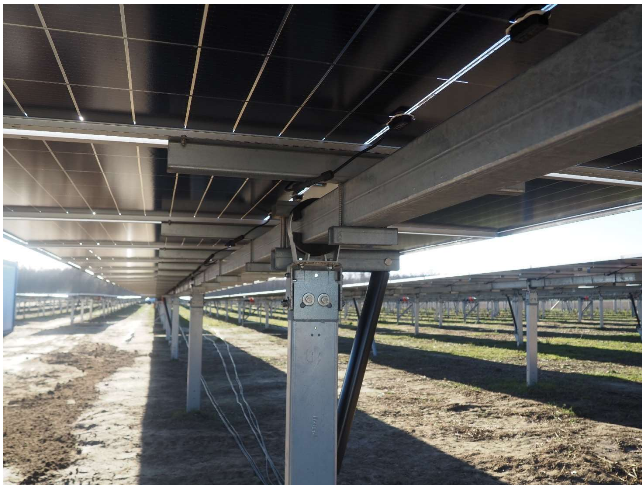
Ryc. 8. Montaż paneli na tzw. trackerach cechują się małym oddziaływaniem na glebę (zdjęcie własne pochodzące z innej zrealizowanej farmy fotowoltaicznej).
