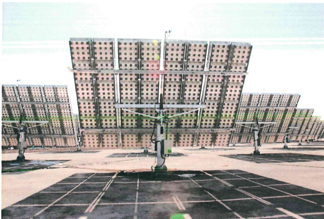
Rysunek 11. Przykładowe panele z systemem trakcyjnym typu „dual axis”.
