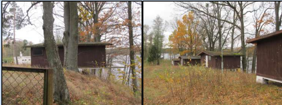
DOMKI POSADOWIONE NA PALACH
