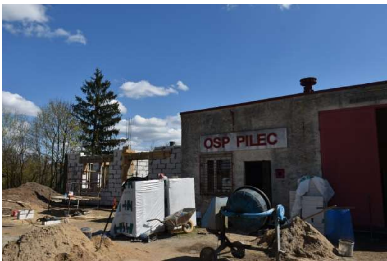
Pilec - remont budynku OSP
