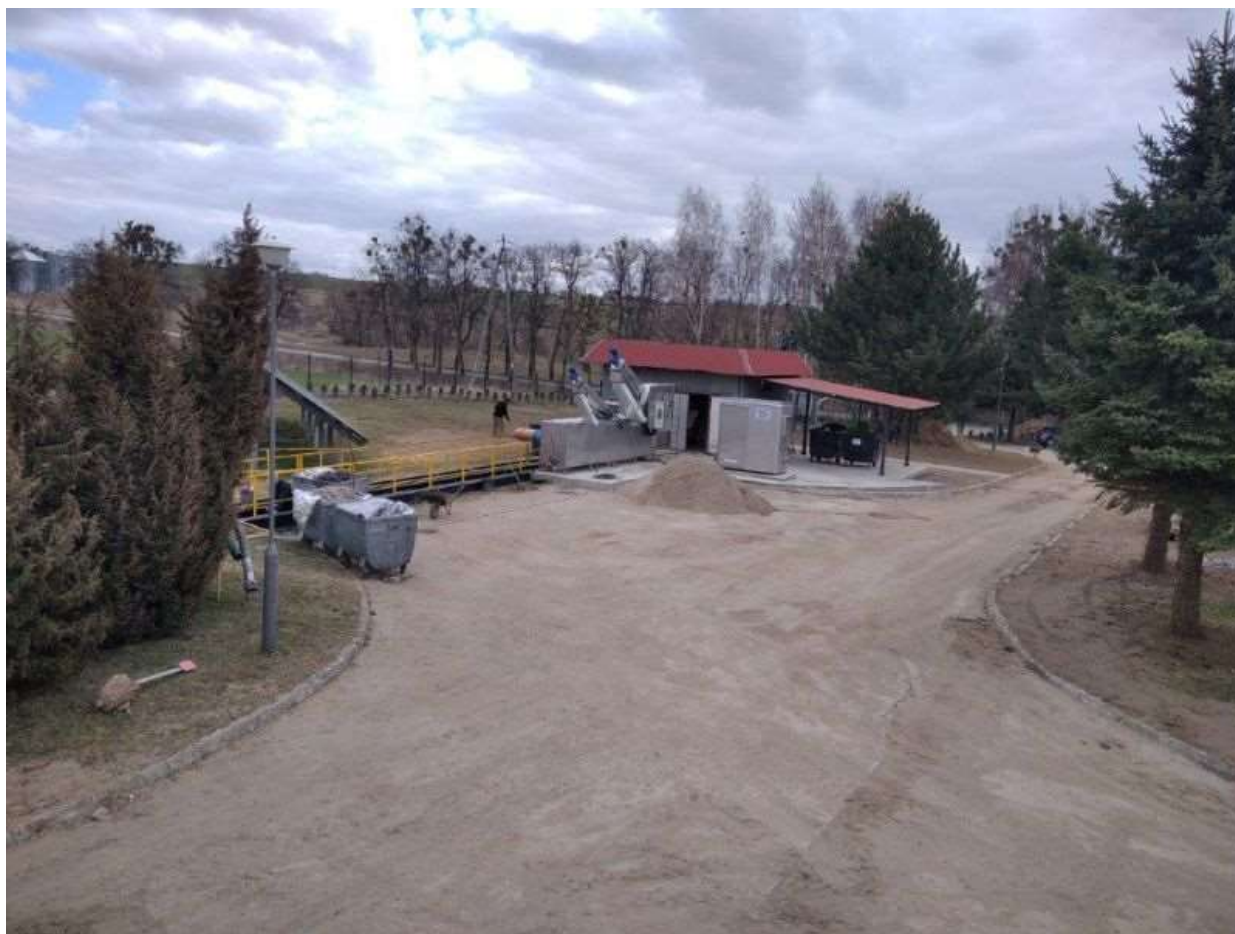
Prace przy oczyszczalni ścieków.
