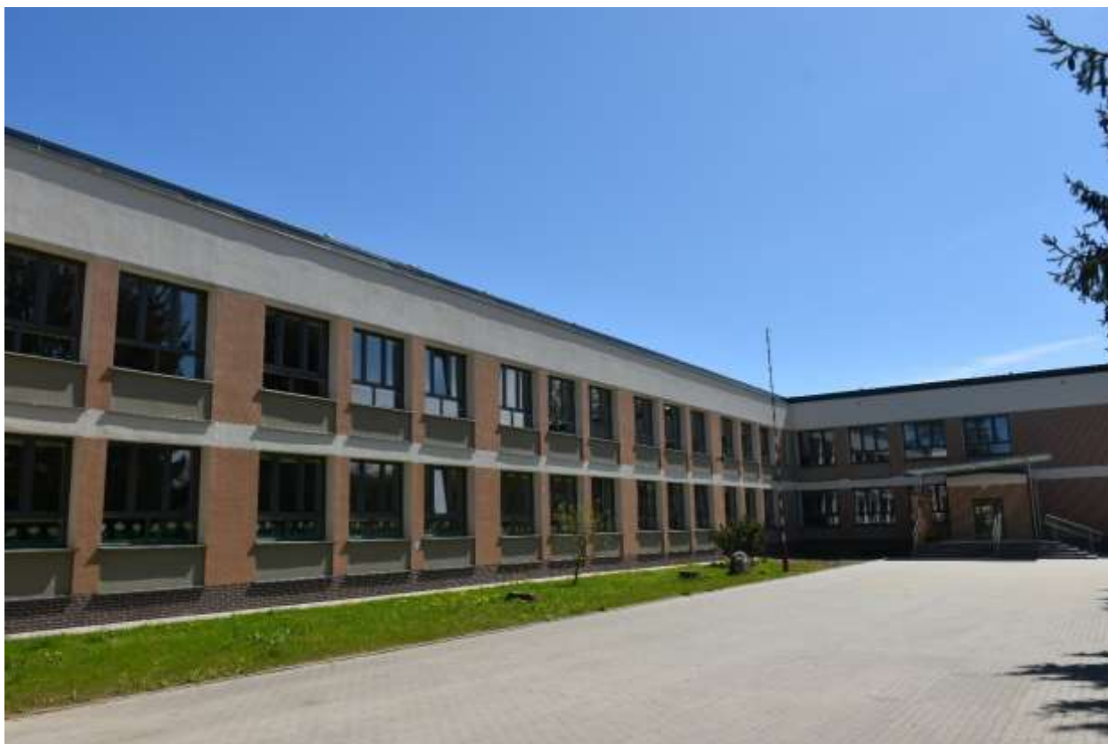
Termomodernizacja budynku Zespołu Szkolno-Przedszkolnego w Reszlu
