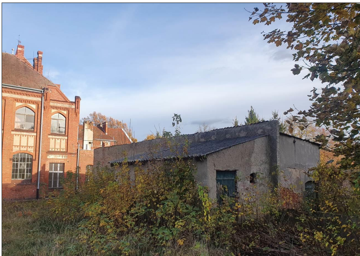
Fot. 5 Widok na tylną elewację budynku szkoły i zdewastowany budynek garażu (fot. własna)
