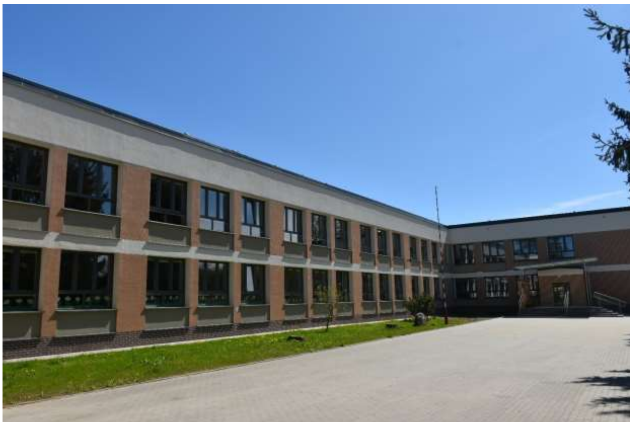
Termomodernizacja budynku Zespołu Szkolno-Przedszkolnego w Reszlu
