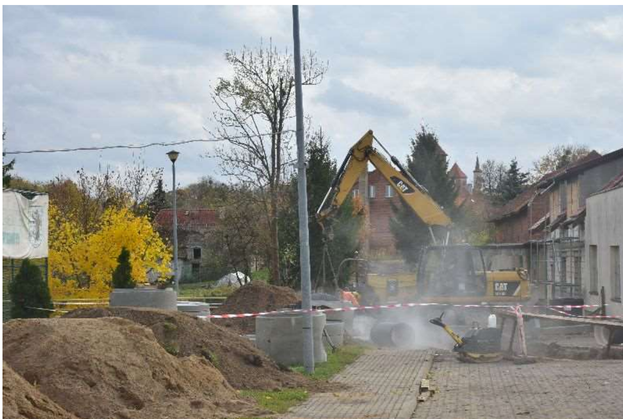
Prace remontowe – kanalizacja deszczowa ul. Warmińska
