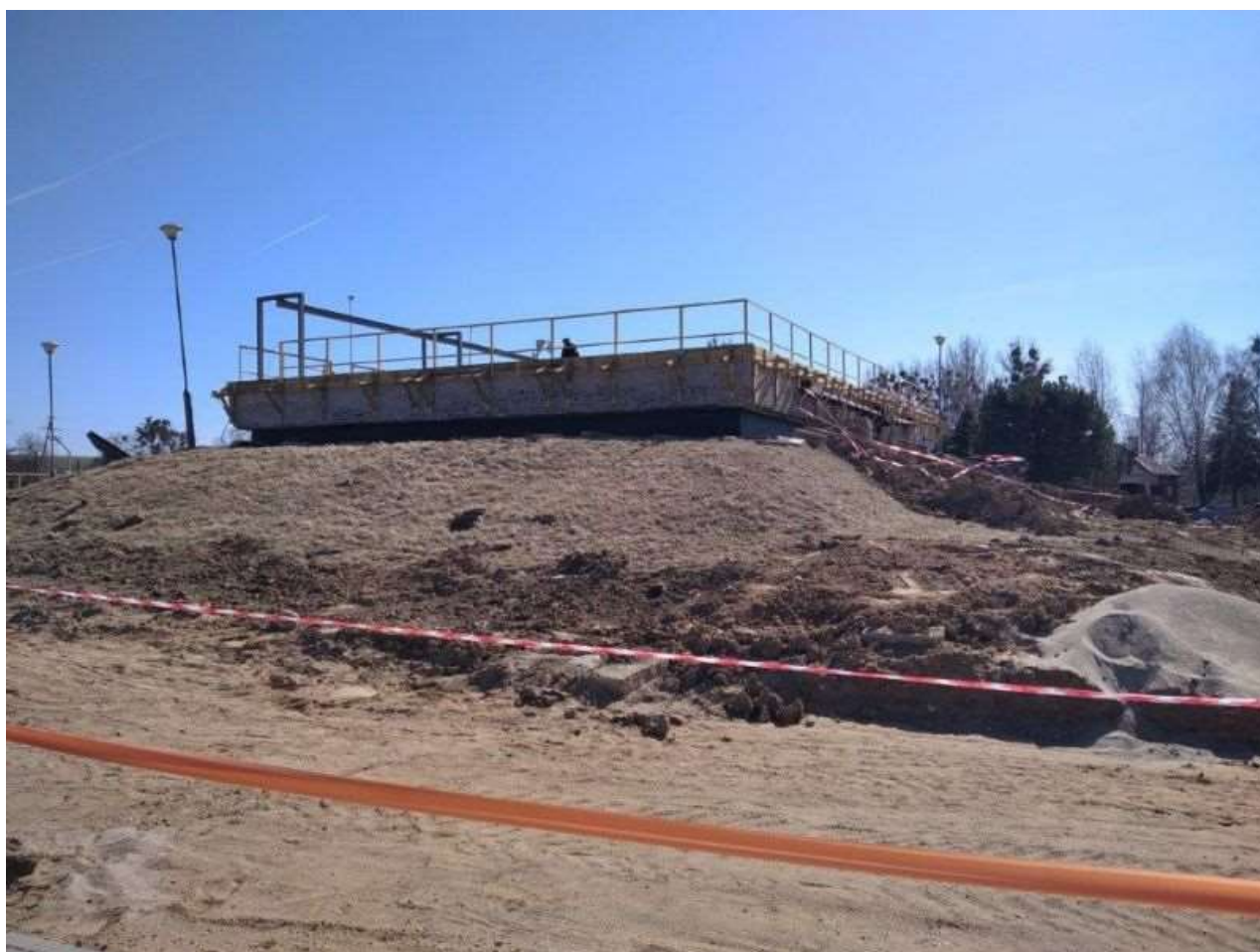
Prace przy oczyszczalni ścieków.
