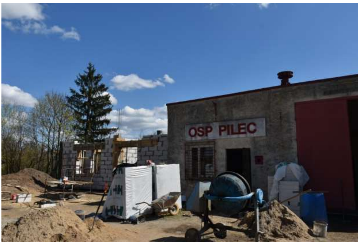
Pilec - remont budynku OSP
